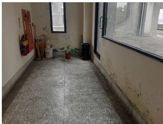
牆面滲水壁癌油漆剝落
